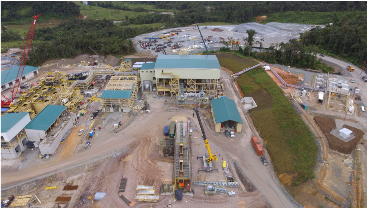
Figura 3. La construcción de la planta de procesos tiene un 80% de avance al 31 de mayo de 2019
